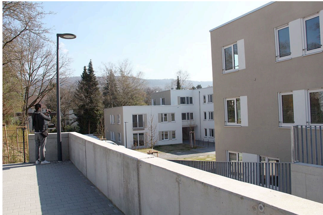
Blick in den tiefliegenden Hof
