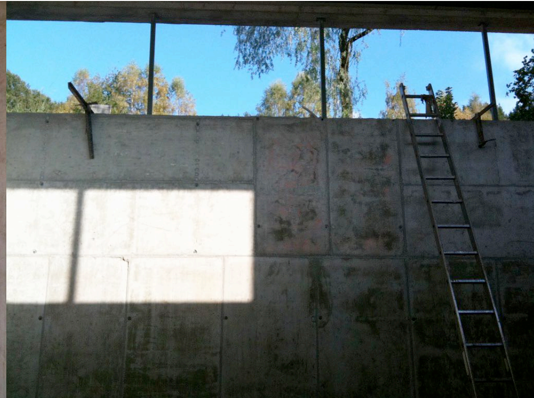
Südfassade nach Sanierung
