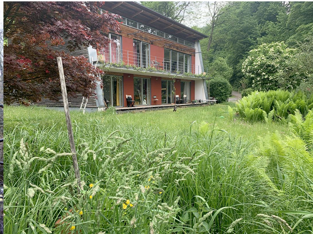
Südfassade nach Sanierung
