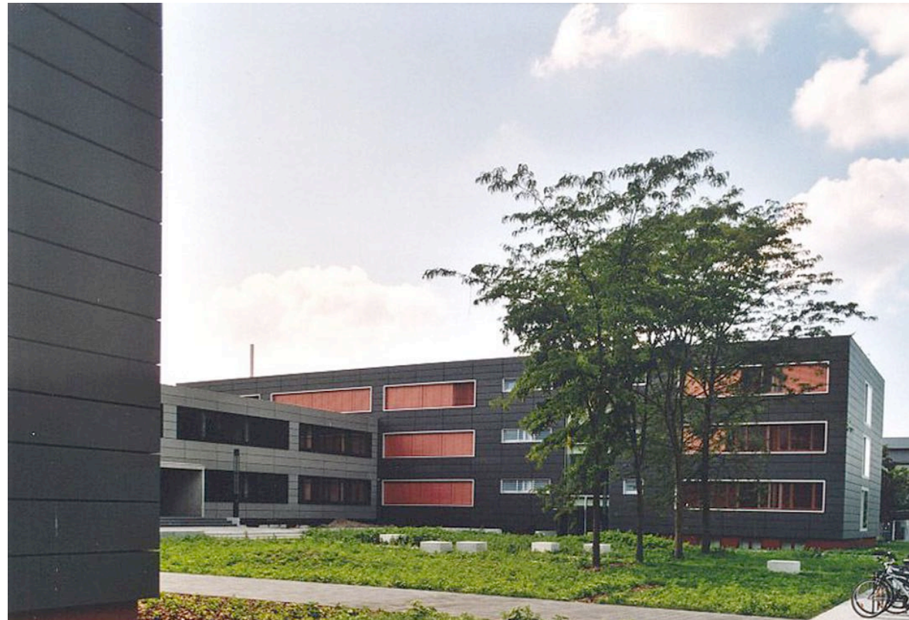
Fassadeneindruck nach Umbau und Sanierung
