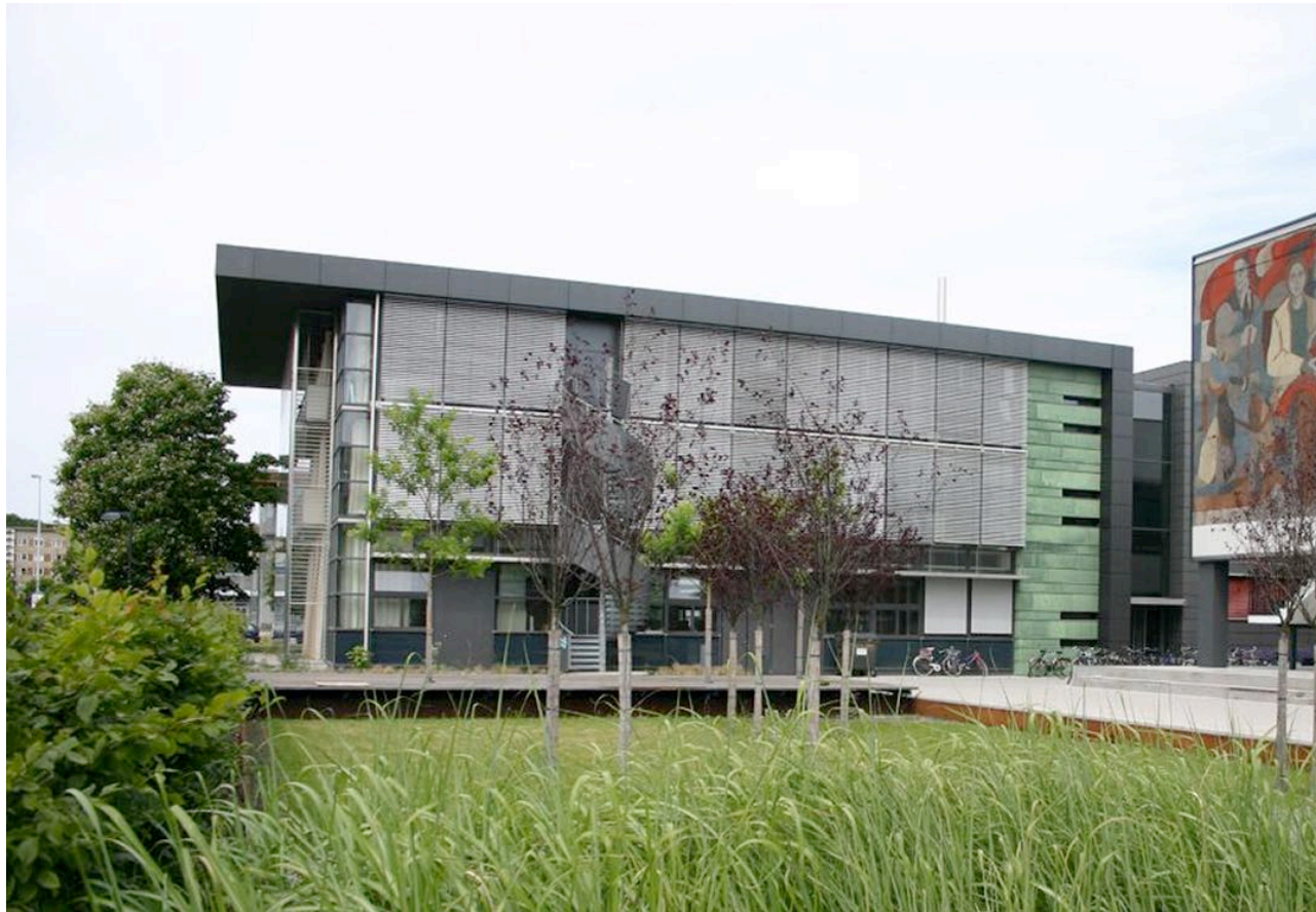
Atelier Kopfgebäude Lehrgebäude 6 + 7
